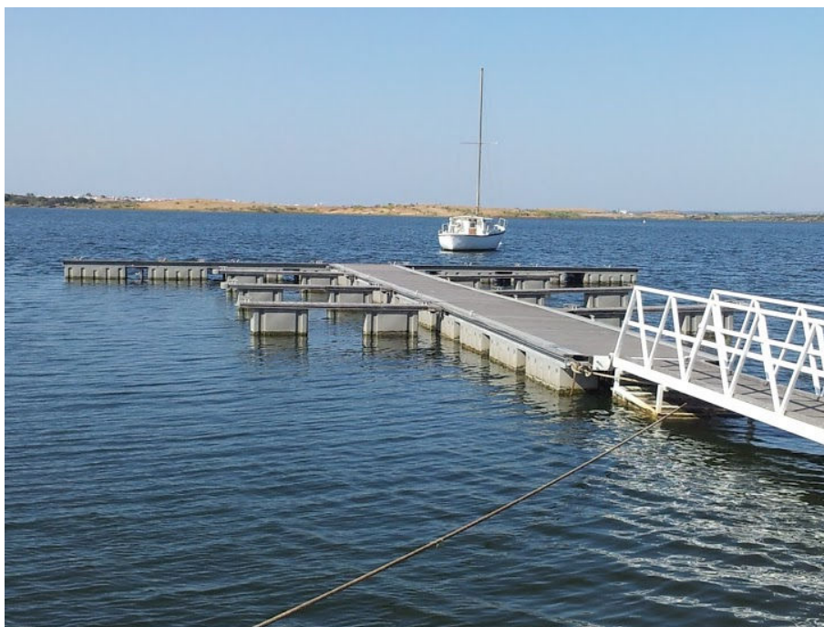
Figura 72 – Cais do Mourão
